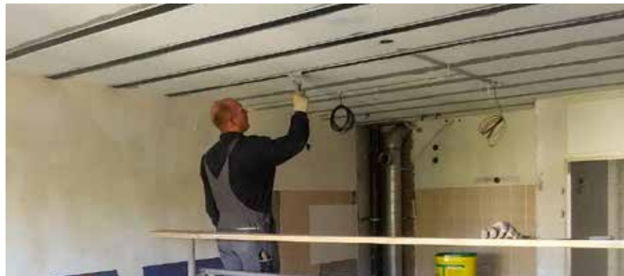
Aanbrengen van lamellen voor het versterken van een betonvloer.
