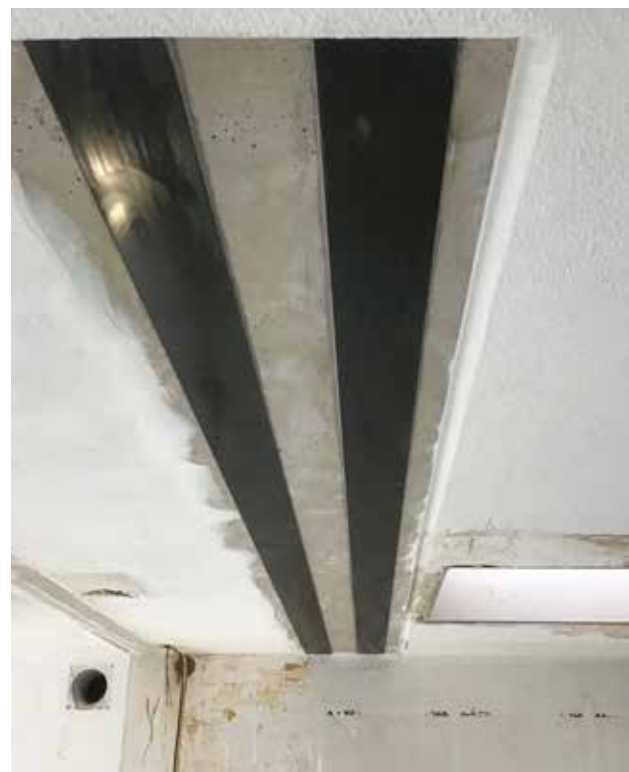
Carbon werd in de bouw nog weinig toegepast. Met de ontwikkeling van wapeningsstroken op basis van carbon is daar snel verandering in gekomen.
